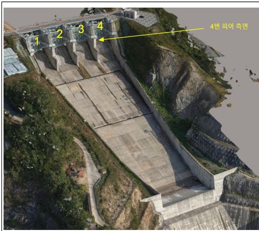
a. 균열분석 대상지(댐본체 Pier4. 우측면)
