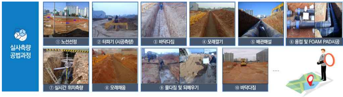
(그림 2) 지하시설물 노출시설물 실시간측량 현장실사 방법
